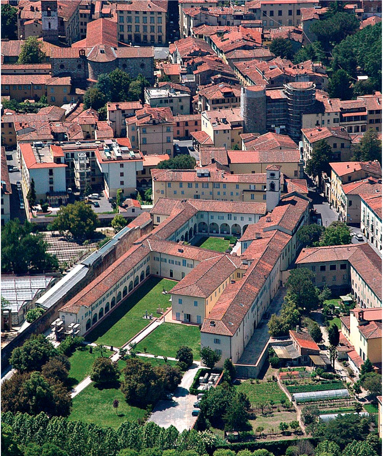
Complesso di San Michele, veduta aerea
