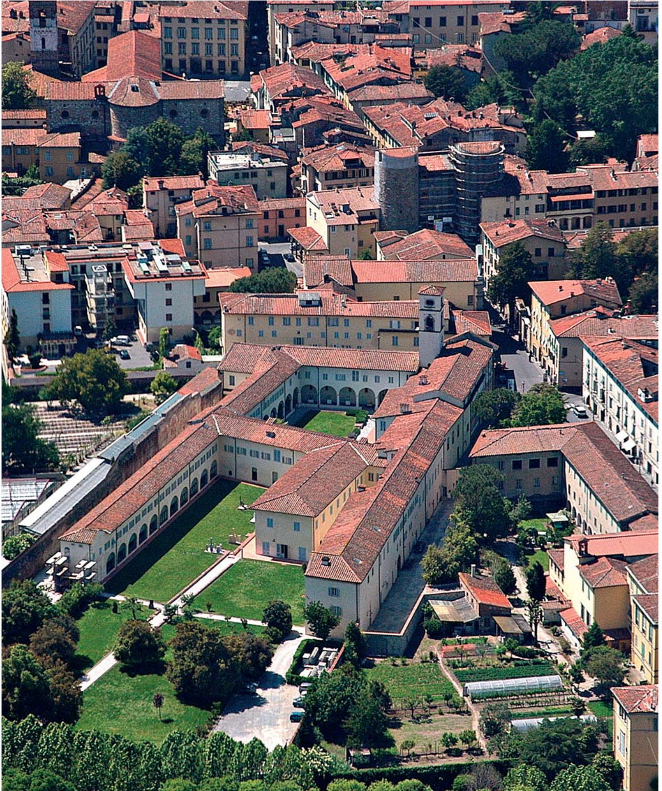
Complesso di San Michele, veduta aerea
